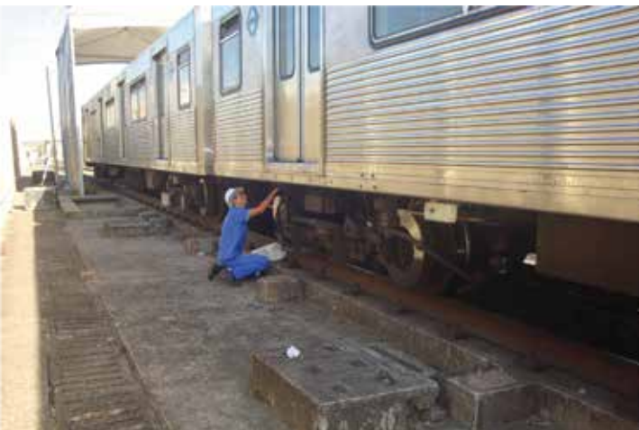
INSTALAÇÃO DO CBTC (Communications-Based Train Control) nos trens das frotas E, G, H, I, J, K e L da Cia do Metropolitano de São Paulo – Metrô ASSEMBLY OF CBTC (Communications-Based Train Control) Cia do Metropolitano de São Paulo – Metrô
